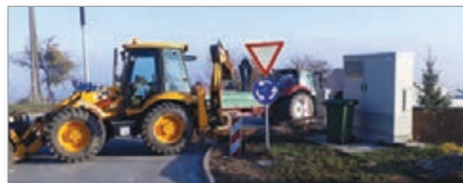
Izvedba del pri obnovi vodovoda Peščeni Vrh
